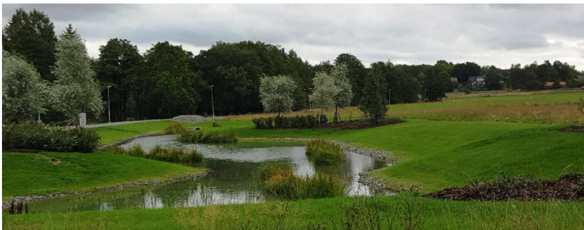
Exempel på dagvattenhantering i öppen damm.
