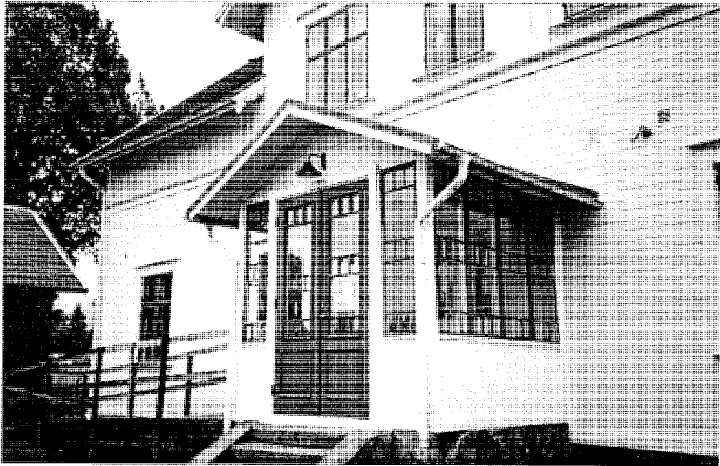
Bild 14: Glasverandan på det östra skolhuset
