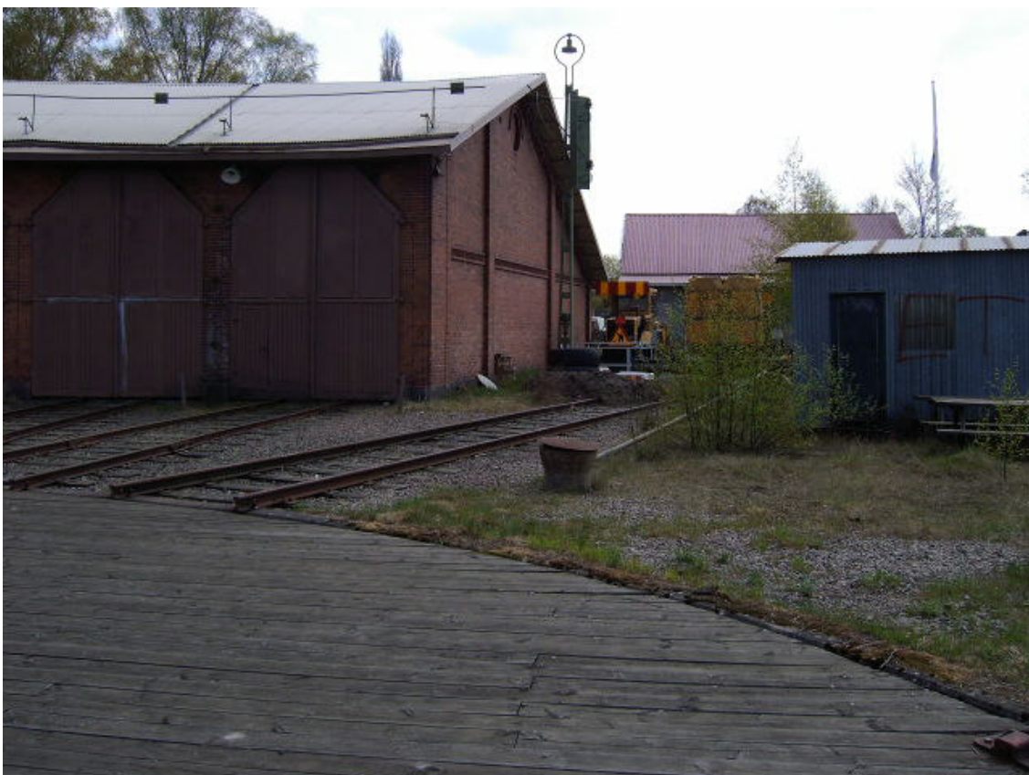
Hr 4. Del av lokstallet och uppställnings- och tankspåret till cisternerna i bild Hr 3.
