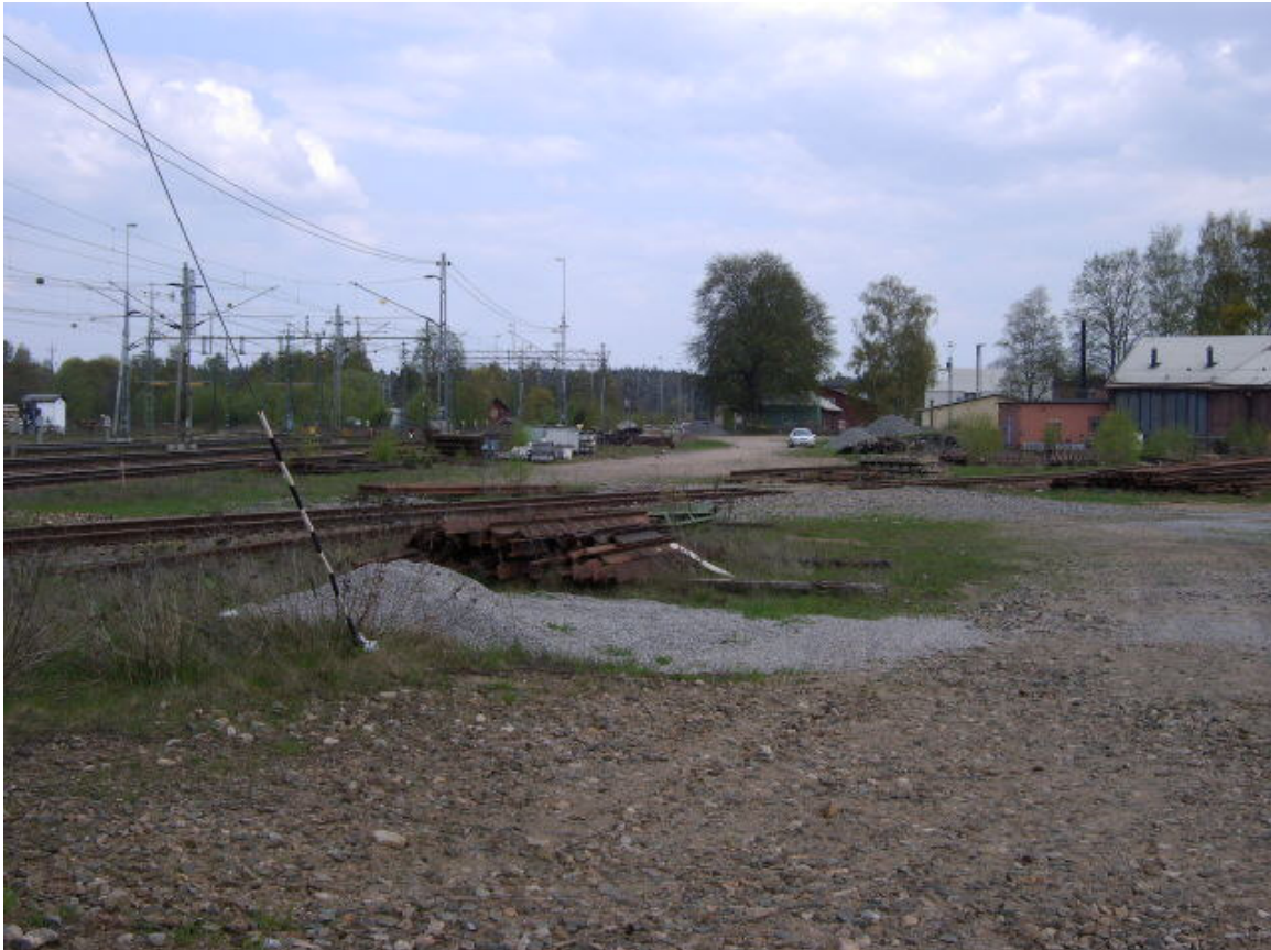
Hr 10. Mindre upplag vid ytan mellan lokstallet och spåren.
