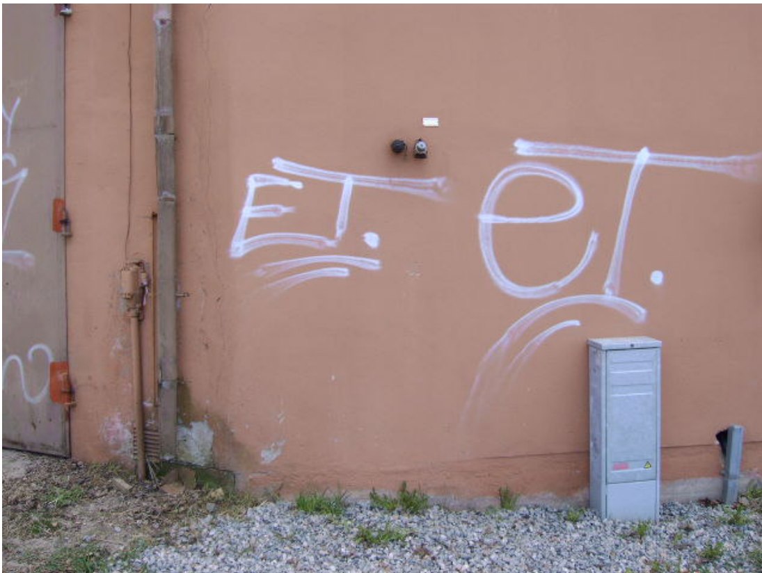
Hr 2. Påfyllningsrör för eldningsolja till en eldningsoljecistern på 6000 l i pannrummet vid bussgaraget.
