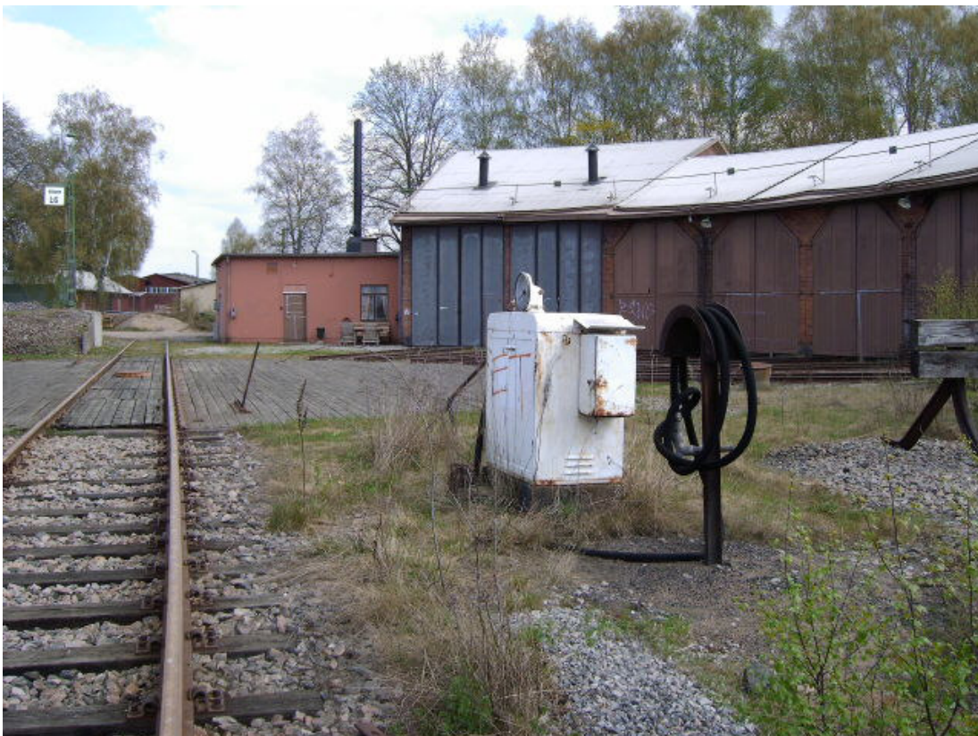
Hr 6. F.d. dieseltankning vid lokstallet. Pumpen var antagligen kopplad till dieselcisternerna i bild Hr 3.
