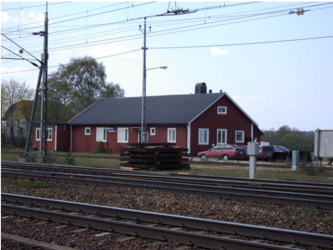
Hr 12. Hus 15 B. Eldningsoljecistern på 3 000 l i dess pannrum.
