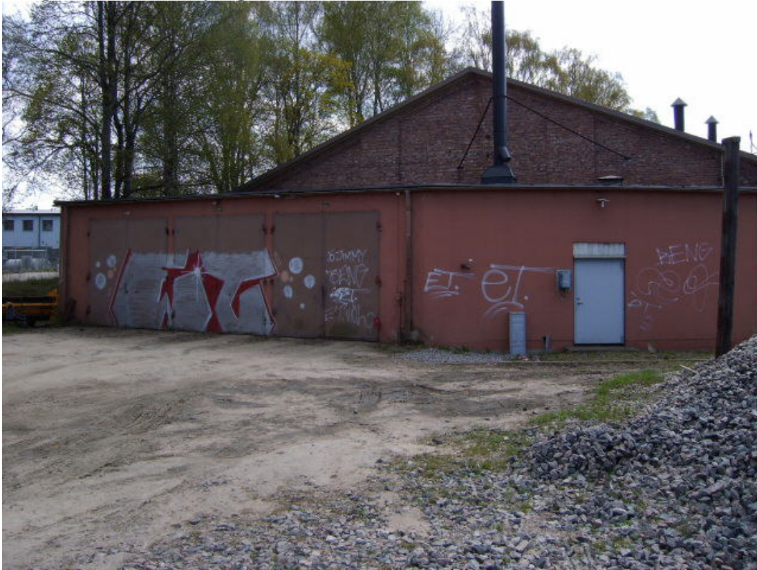
Hr 1. F.d. bussgarage vid lokstallet.
