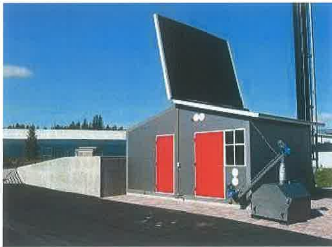
Figur 4.1. Exempel mobil panncentral, finstiltillverkad MegaCont, 400 kW.
