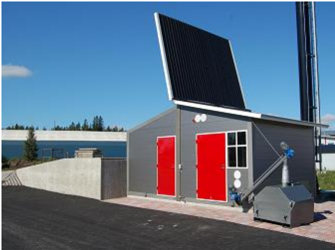
Figur 4.1. Exempel mobil panncentral, finstiltillverkad MegaCont, 400 kW.
