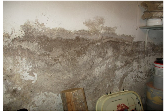
Fuktskador i källaren
