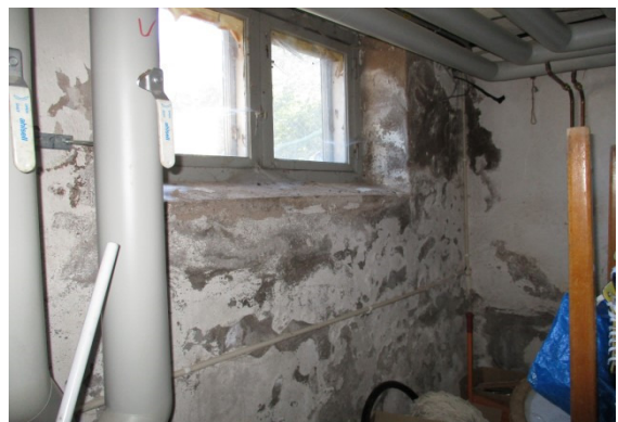
Fuktskador i källaren
