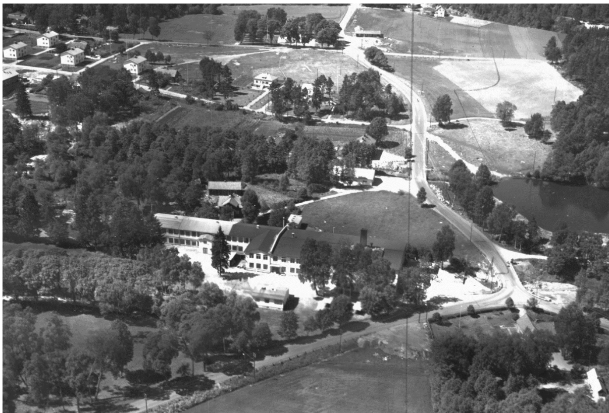
Flygfoto över Annelund med armaturfabriken i förgrunden, 1953. Källa VMOL09871, Vänersborgs museum/Digitalt museum.
