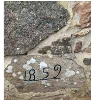
Husgrund vid kvarnbyggnaderna.
