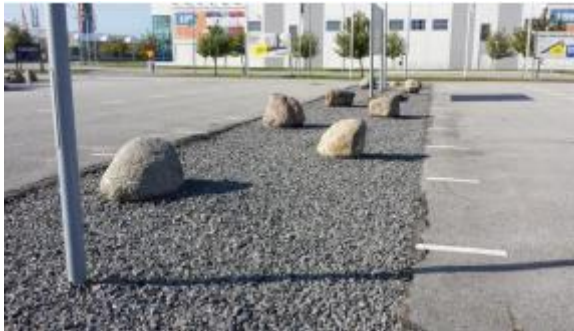
Figur 21 Exempel på utformning av krossdike.
