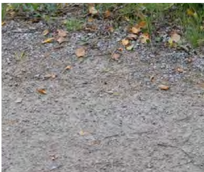
Figur 15. Stenmjöl med kalk, växligheten har svårt att etablera sig i den hårda beläggningen.
