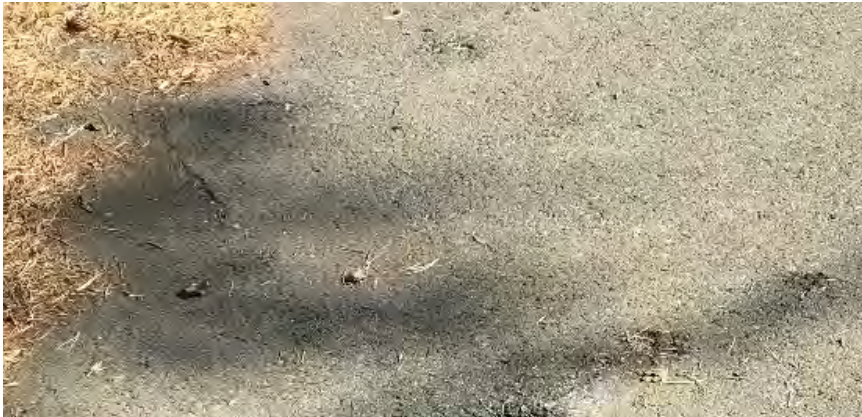
Figur 16. Exempel på sprickbildning i asfalt pga rötter. Upplevs som svåråcyklat pga kraftiga vibrationer.
