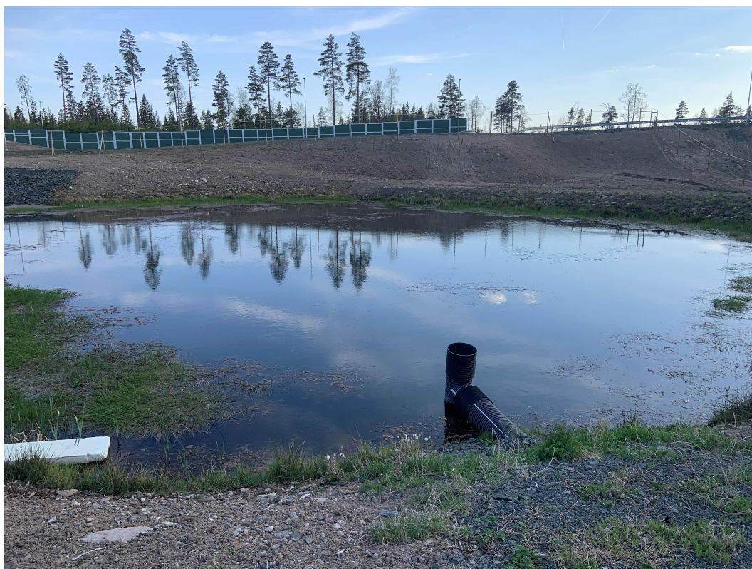
Foto 2. Exempel på en relativt nyanlagd våt damm. Utsläppsanordningen syns i förgrunden (foto David Karlsson).
