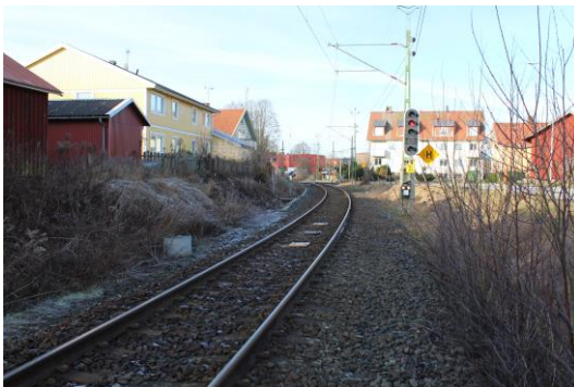
Bild 2. Vy över spårområde vid km 91+200.
