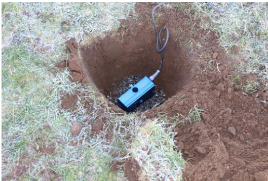
Bild 4. Exempelbild från montering, mätpunkt 2 före jordtäckning.
